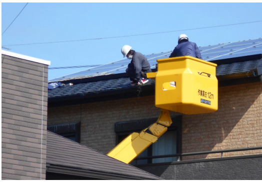
屋根作業の様子
