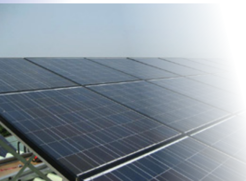
太陽光発電システムの設置
